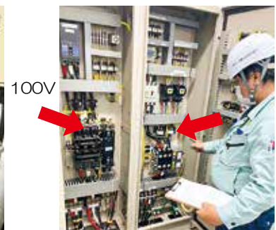
●電源の自動切換え点検
