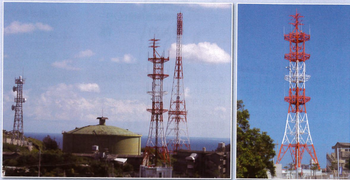
※おきなわ TOWER 上部に㈱ラジオ沖縄の FM 補完放送局アンテナが設置されました。
