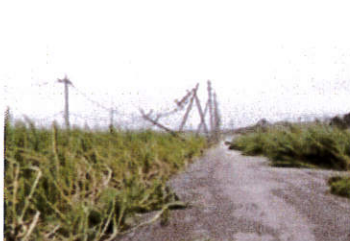
現地被害状況(電柱倒壊)
