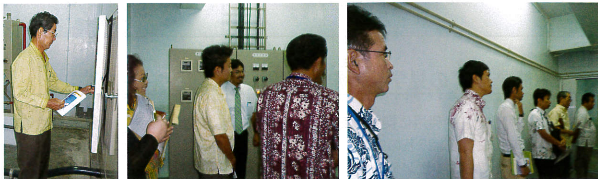
センター発電機室(デルタ電気工業(株) 新垣取締役の説明)
