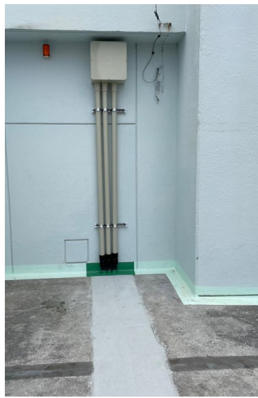
局舎電柱側引き込み
