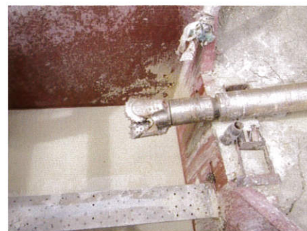
地層を削る先端ドリル(ビット)
